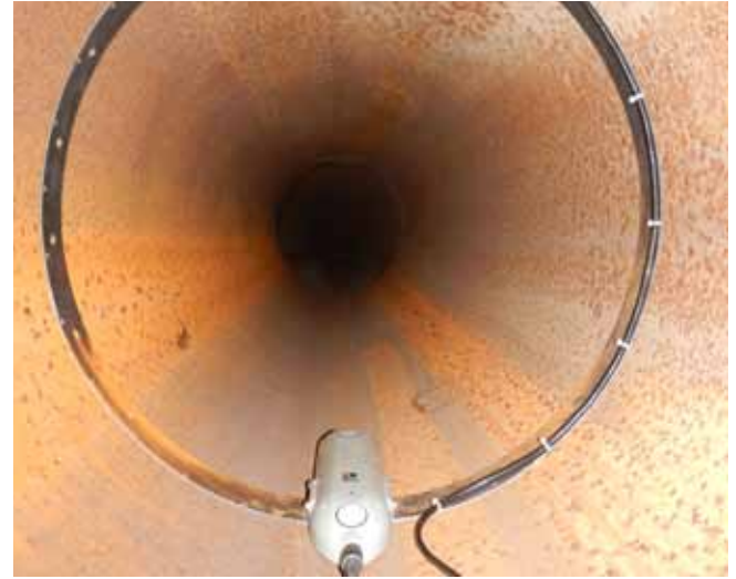
専用の設置リングを使用して、SonTek-IQ Pipeを簡単に設置できます。設置リングは直径41~91 cmの管に使用できます。
